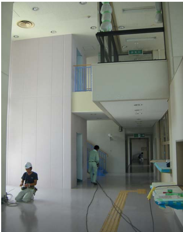
事務所前から地下～2階を結ぶエレベーター
